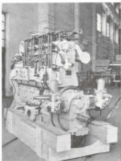
Motor Diesel marine tipo 2120/4 S
